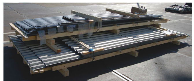
Mavotrans® poerbekisting wordt prefab als platte elementen op de bouwplaats aangeleverd
